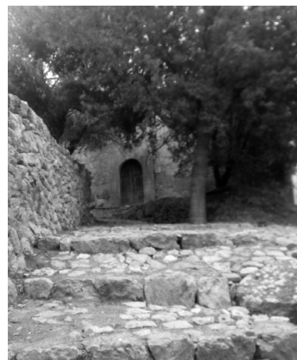
Arranjament del camí de Biniarroi
